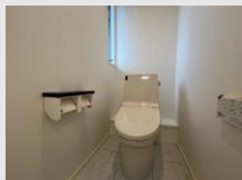
2階にもトイレ/洗面台を設置 忙しい朝も安心
