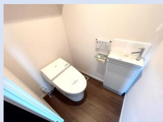
手洗いカウンター 温水洗浄便座付き 機能的なトイレ
